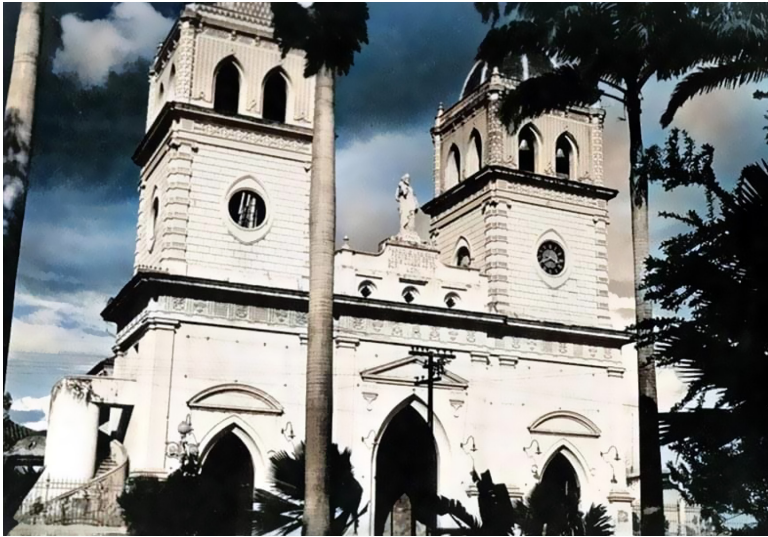
Figura 47. Vista de la fachada y acceso a torres - Década de 1940
