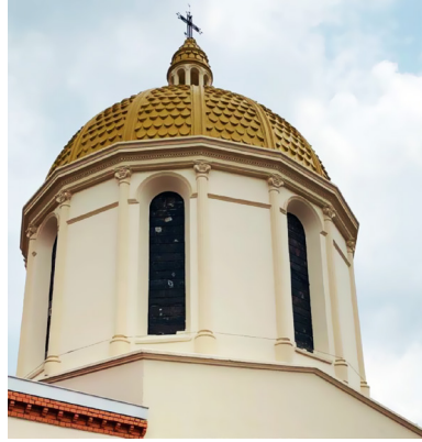
Figura 32. Vista exterior de la cúpula y su estructura
