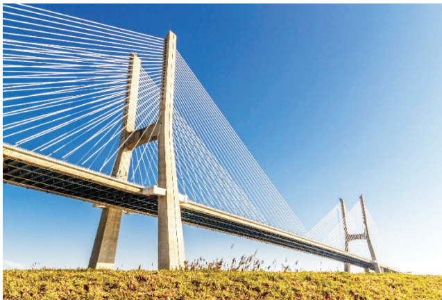
Figura 97. Puente con pilonos
