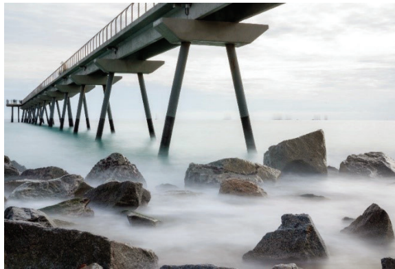
Figura 95. Puente con pilares inclinados
