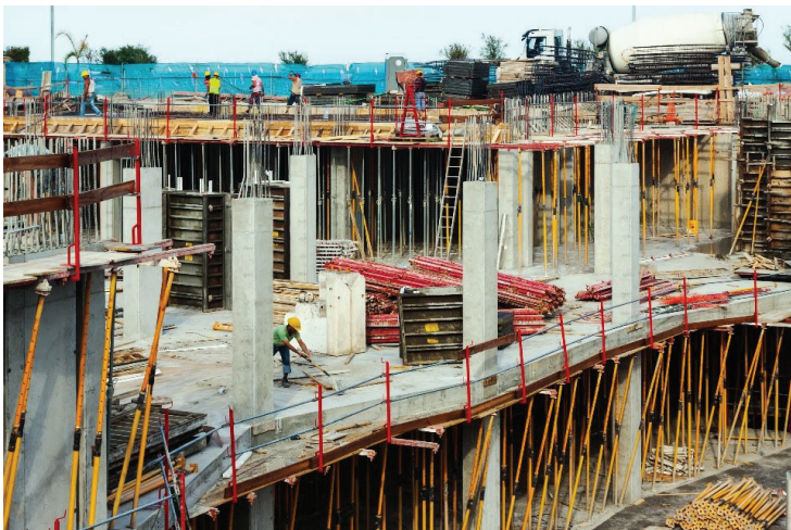
Figura 82. Encofrado losa entrepiso
