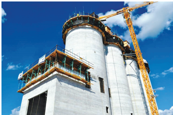
Figura 87. Encofrado deslizante
