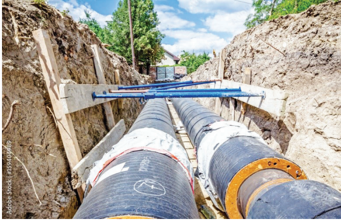
Figura 64. Excavación entibada
