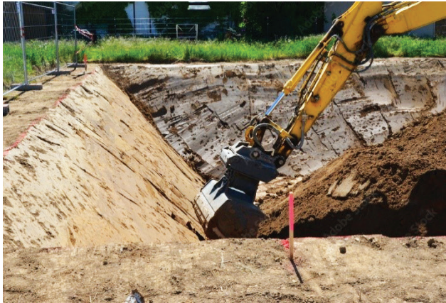
Figura 63. Excavación con talud
