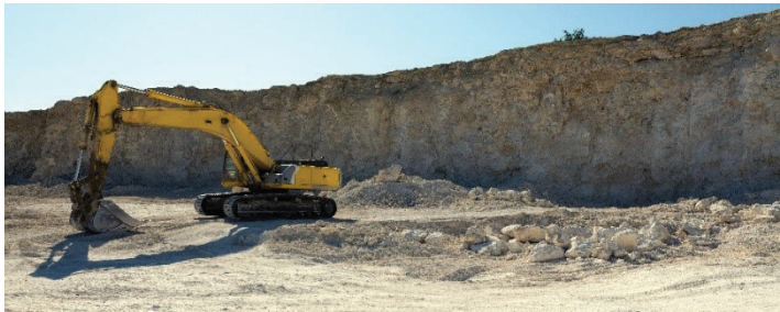
Figura 33. Excavación a cielo abierto
