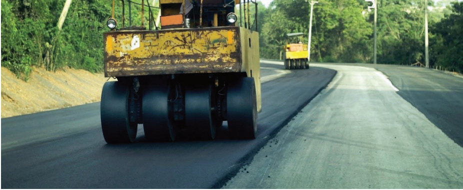
Figura 54. Compactador de neumáticos
