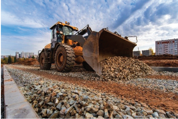
Figura 31. Extendido del material
