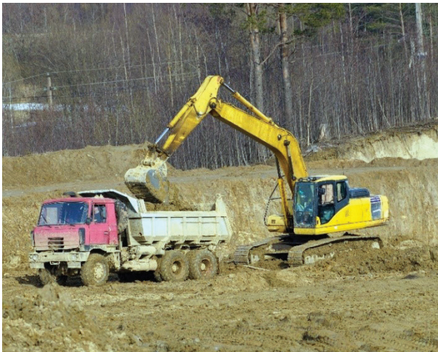
Figura 28. Carga de material excavado
