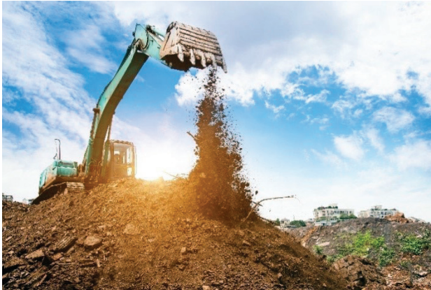
Figura 27. Excavación con retroexcavadora
